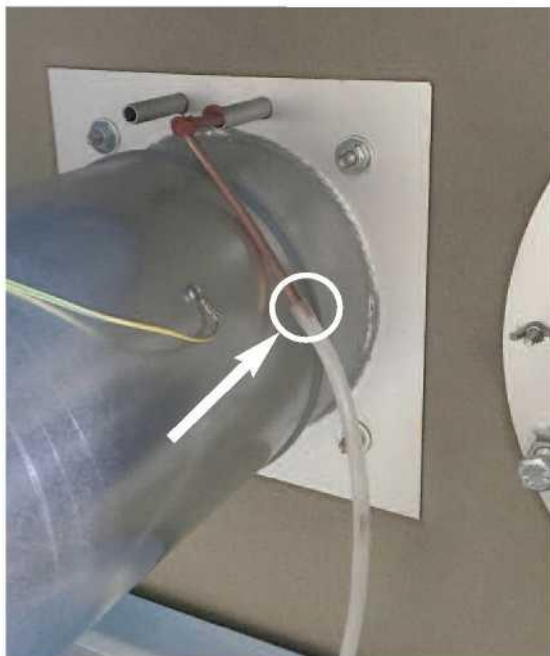
Fig. 7.1 Detaliu tub conectare presostat
